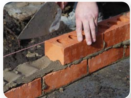
Met cement blijven de stenen stevig op elkaar liggen.
