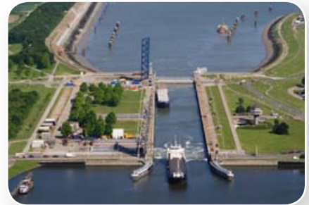
Als het water in een rivier en een kanaal niet even hoog staat, moet een schip door een sluis.
